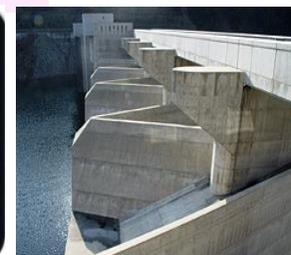
これは越流堤をジグザグ型にして堤長を長く取ることで、同じ越流幅でも直線型より放流量を多くすることができる特徴があります。
